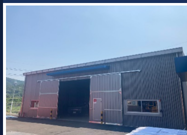
작업 동(포장, 보수작업공간)
