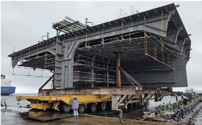
UPP DECK 운송
