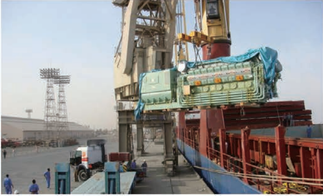
IRAQ MOE 900MW SITE PJT
